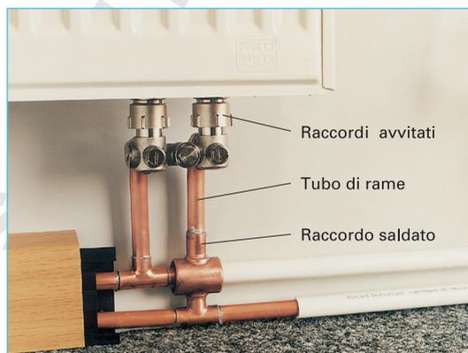
Figura 3: Raccordi avvitati
