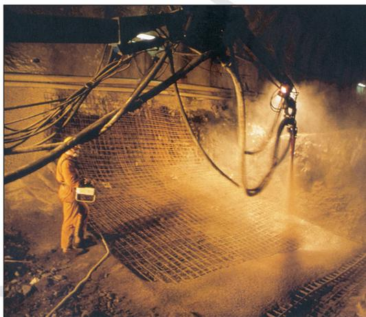
Figura 3: calcestruzzo spruzzato a umido nella costruzione di gallerie.
