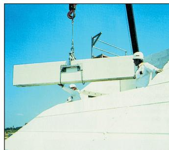
Figura 2: posa di lastre per tetti in calcestruzzo cellulare.
