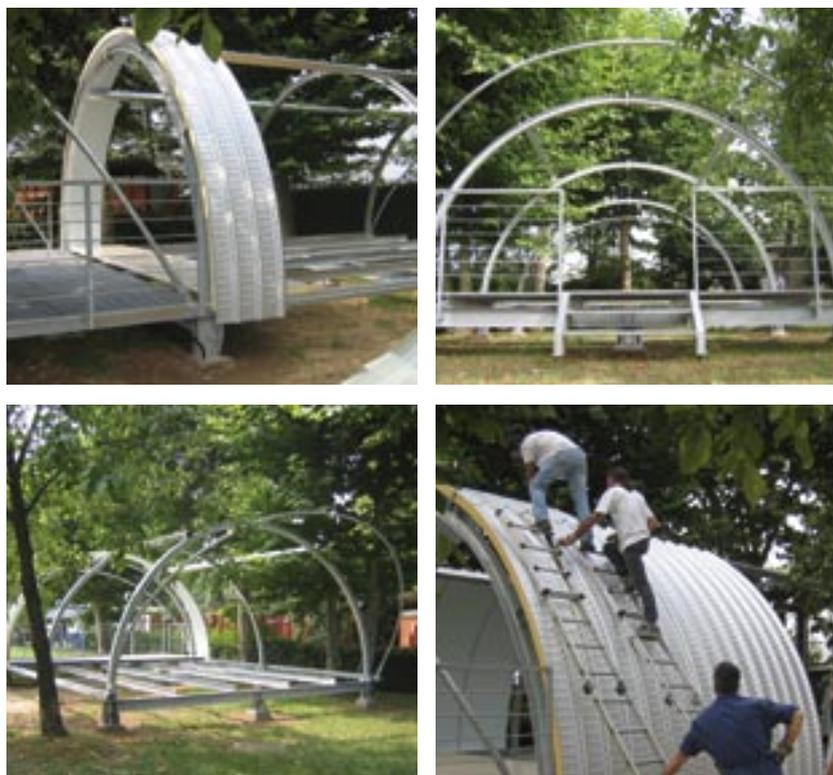
“L’Armadillo si monta come un meccano perfetto in pochi giorni su una fondazione ben ancorata a terra. Sopra lo “scheletro” metallico, leggero e resistente, si fissano i pannelli Elycop che collaborano anche all’irrigidimento del sistema.
