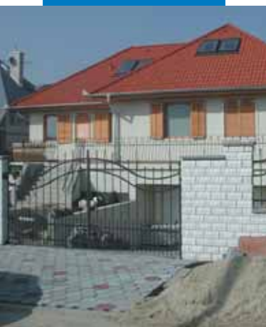
Villa privata con isolamento termico a cappotto - Ungheria
