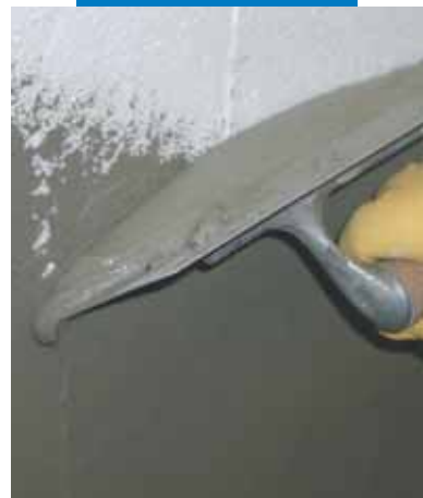
Rasatura di pannelli termoisolanti: stesura di Mapetherm AR1
