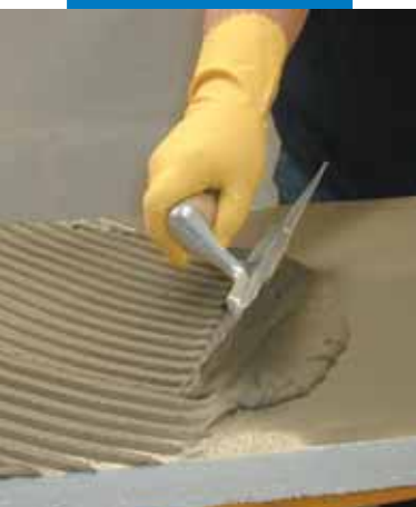
Applicazione di Mapetherm AR1 sul rovescio del pannello con spatola dentata
