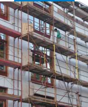
Incollaggio delle lastre coibenti alla facciata con Mapetherm AR1
