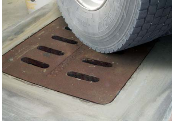
Sigillatura di un chiusino stradale (per le classi vedi Campi di applicazione).
