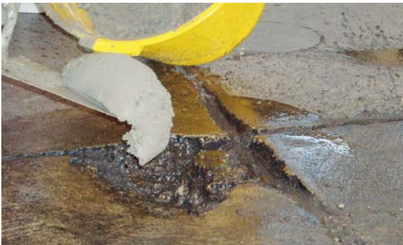
Riparazione di una pavimentazione industriale in cemento e fissaggio di un tirante molto sollecitato
