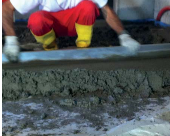
Stesura del massetto SUPERCEM PRONTO.
